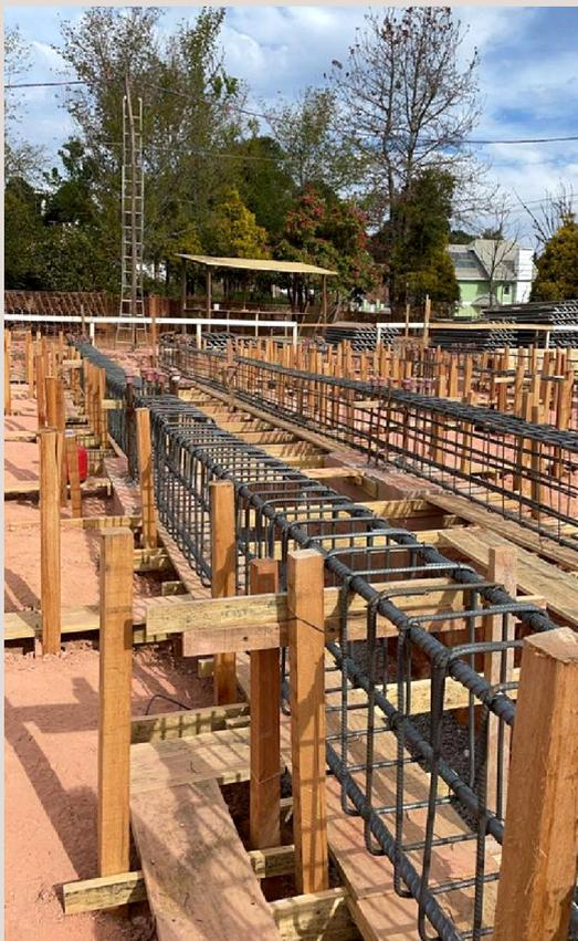
As ferragens da estrutura da primeira laje estão sendo montadas para iniciar o processo de concretagem da sua casa de férias em Campos do Jordão! Está sendo executado também a estrutura da galeria onde ficarão as instalações hidrossanitárias centrais do empreendimento e a escavação do poço dos elevadores.
